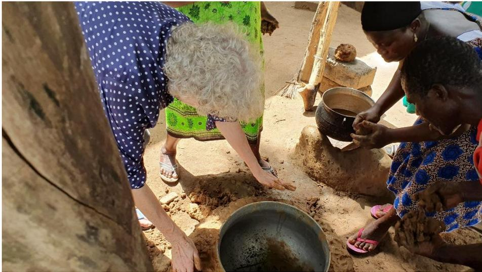
Dann wurden die Wände mit den Maiskolben geglättet, die Ränder geradegemacht, der Brennkammer wurde mit der Machete ausgehöhlt, der Boden mit Lehm mit der Hand gestampft, 3 Kaminzüge mit Machete und Händen geformt... und endlich der Topf entfernt! Der ganze Bau hat 2,5 Stunden gedauert... und endete mit einem Freudentanz um den Ofen, der alle Frauen in Gesang und Lachen vereinte.
