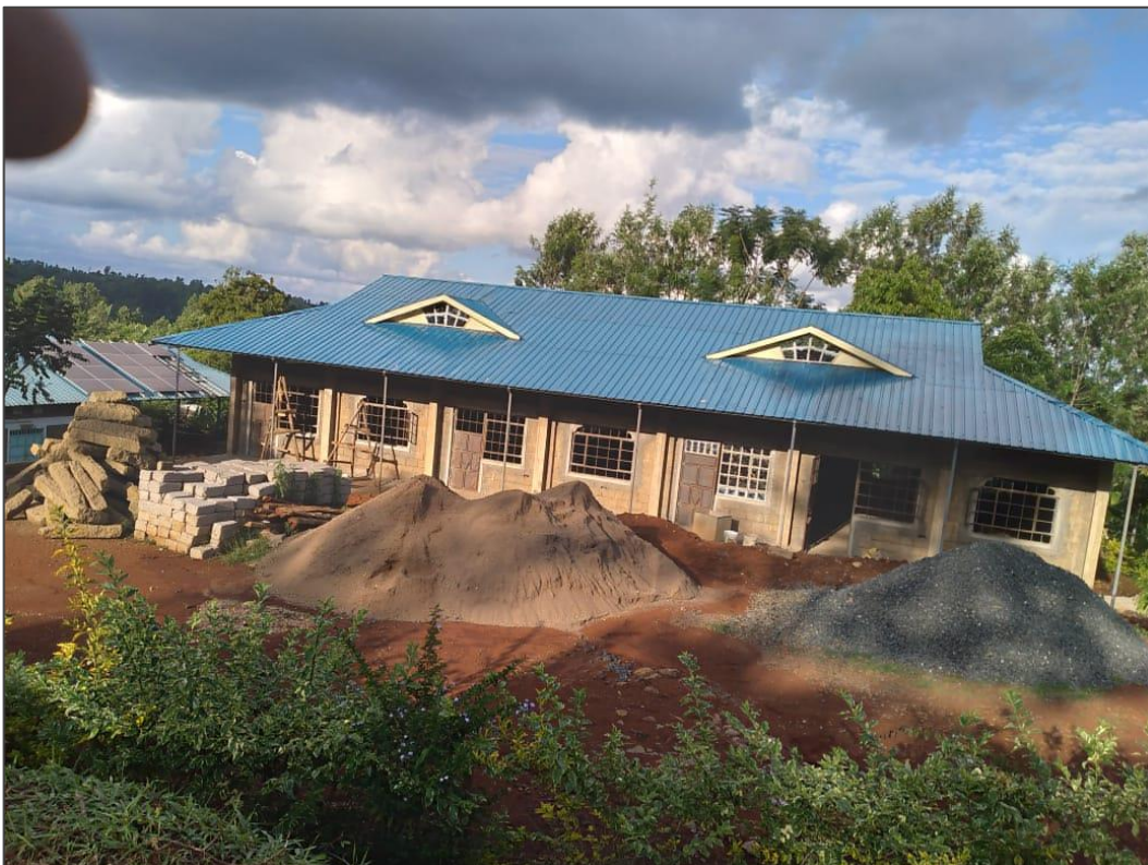
Der neue erste Stock des Schulgebäudes
