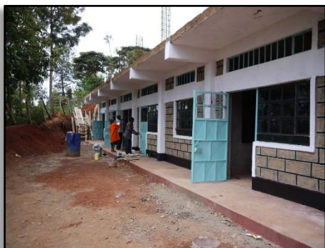
Letzter Schliff für das Schulgebäude
