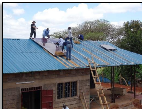
A. Plüster zeigt, wie Solaranlagen installiert werden
