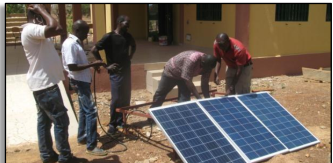
Fünf informell ausgebildete Elektriker bei der Montage einer 300 W Anlage
