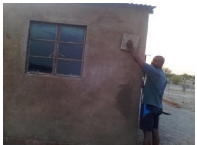
Bild: das Lagerhaus erhält den letzten Schliff
